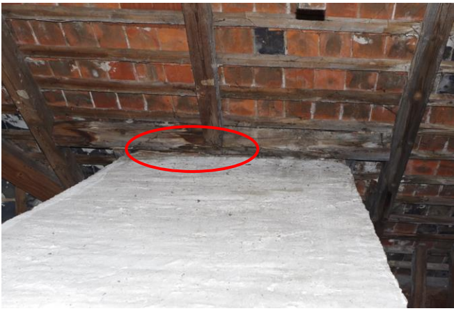
Fot. 4. Miejsce przebywania pojedynczych nietoperzy w szczelinie pomiędzy kominem a dachem w południowo zachodnim rogu strychu.
