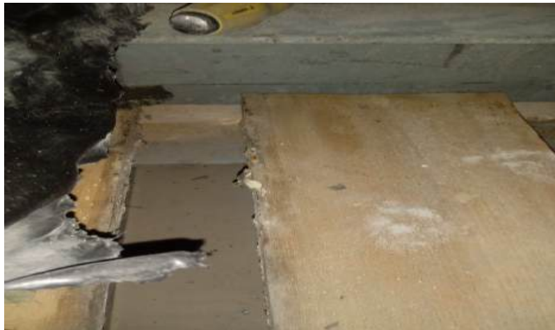
Fot. 67. Skrzydło frontowe – po remoncie. W odsłonięciu widoczna blacha fałdowa oraz, na dole przykładka więzara głównego C260, u góry belka stalowa INP240 (w miejsce belki drewnianej)
