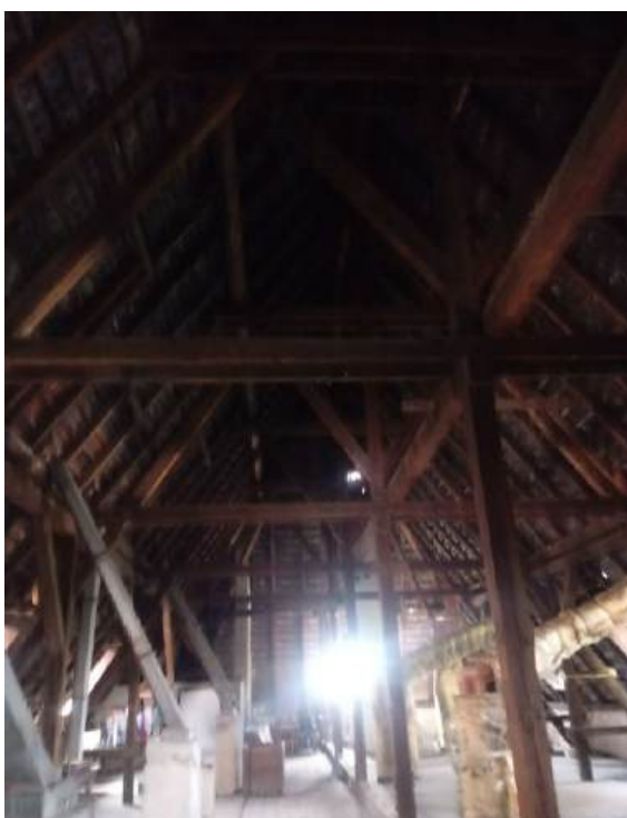
Fot.45. Widok więźby dachowej – skrzydło boczne część c. Na dawnych kominach wyprowadzono nowe kanały wentylacyjne.
