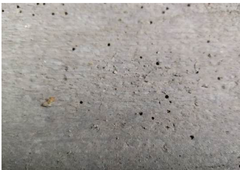
Fot.56. Ślady zerwania ksylofagów /kołatek/ na deskach podłogowych; zerowanie miejscowe, nie zaobserwowano aktywnej formy owadów.
