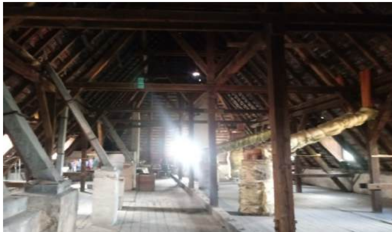
Fot.58, 59 Widok ogólny poddasza w skrzydle c. Nadciąg podwieszony do wieszaków wiazarów głównych wieszarowych. Widoczne śruby – podwieszenie belek stropowych. Podłoga oryginalna drewnana. Analogiczna konstrukcja więźby w skrzydle a (lustrzane odbicie skrzydła c).
