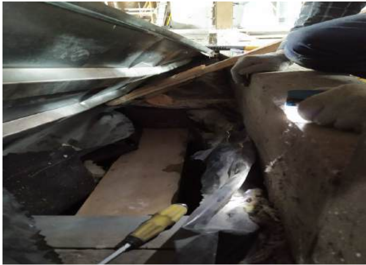
Fot. 67. Skrzydło frontowe – po remoncie. W odsłonięciu widoczna blacha fałdowa oraz, na dole przykładka więzara głównego C260, u góry belka stalowa INP240 (w miejsce belki drewnianej)
