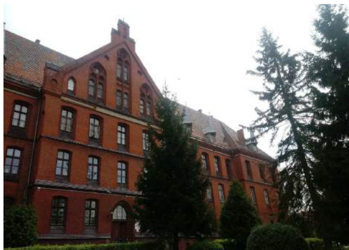
Fot.1., 2. Widok ogólny budynku od strony frontowej.
