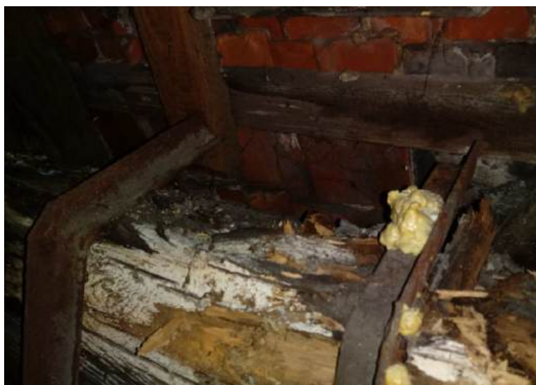
Fot.49. Skrzydło boczne c, przewody wentylacyjne wyprowadzone przy płatwiach; skraplająca się para wodna zawilgaca drewno powodując rozwój grzybów – technicznych szkodników drewna co prowadzi do destrukcji materiału. Pokrycie dachowe z prześwitami/ ubytkami.
