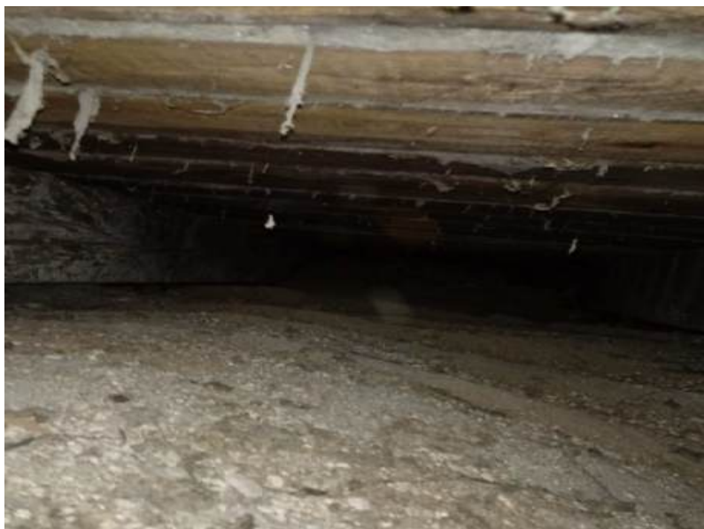
Fot.63. Podłoga i strop nad częściami korytarzowymi. Widoczne na dole sklepienie murowane, powyżej podłoga drewniana na belkach drewnianych.
