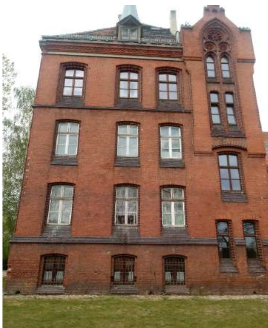
Fot.5. Widok ściany szczytowej skrzydła bocznego -część c. Część a stanowi lustrzane odbicie części c względem skrzydła środkowego b.
