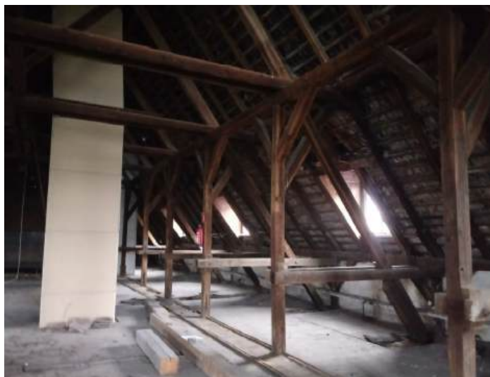
Fot.30. Skrzydło środkowe -część b /widok w stronę części frontowej/. Połąć lekko przesunięta na zewnątrz, połączenie słupów z mieczami wiażarów „rozjechane”. Na podłodze elementy drewniane -belki nieznanego pochodzenia.
