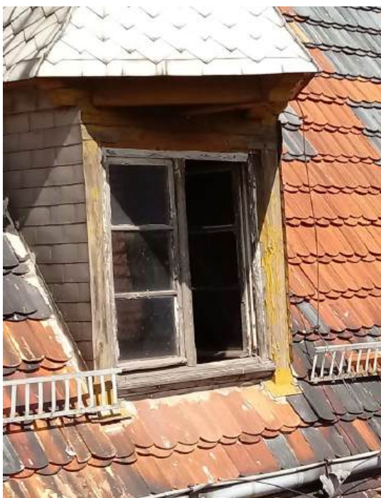
Fot.11. Zbliżenie na lukarnę w połączeniu dachu jw.
