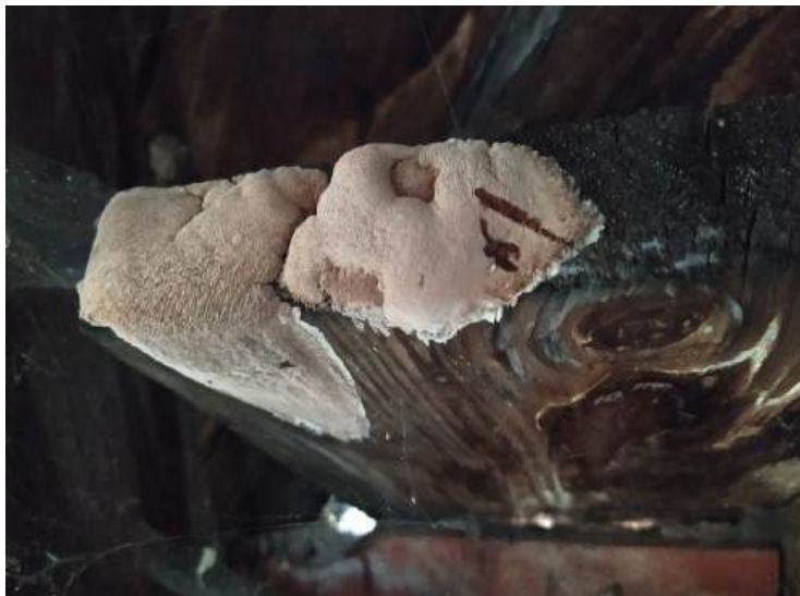
Fot.35. Elementy lukarny jw. porażone przez grzyb domowy biały – techniczny szkodnik drewna, forma grzyba aktywna – owocniki.
