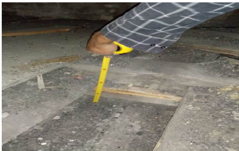
Fot.61, 62. Strop oryginalny, drewniany belkowy ze ślepym pułapem. Występuje w skrzydłach a, b(przy ścianie szczytowej), c oraz w południowej części skrzydła frontowego.
