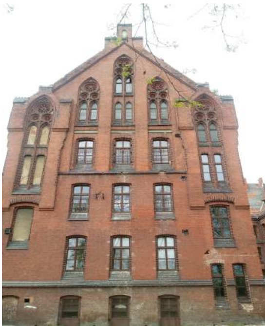
Fot.4. Skrzydło środkowe budynku -część b, widok ściany szczytowej.
