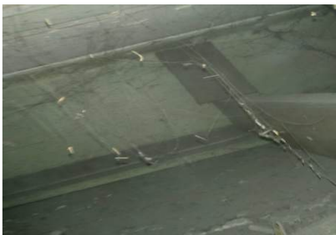
Fot. 65 Na belkach stalowych oparto drewniany strop belkowy ze ślepym pułapem. Obecnie przebudowany. Usunięto ślepy pułap i wprowadzono sufity na podkonstrukcji z kantówek opieranych na dolnych stopkach dwuteowników.
