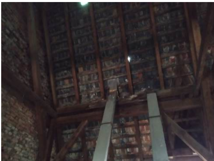
Fot.49. Skrzydło boczne c, przewody wentylacyjne wyprowadzone przy płatwiach; skraplająca się para wodna zawilgaca drewno powodując rozwój grzybów – technicznych szkodników drewna co prowadzi do destrukcji materiału. Pokrycie dachowe z prześwitami/ ubytkami.
