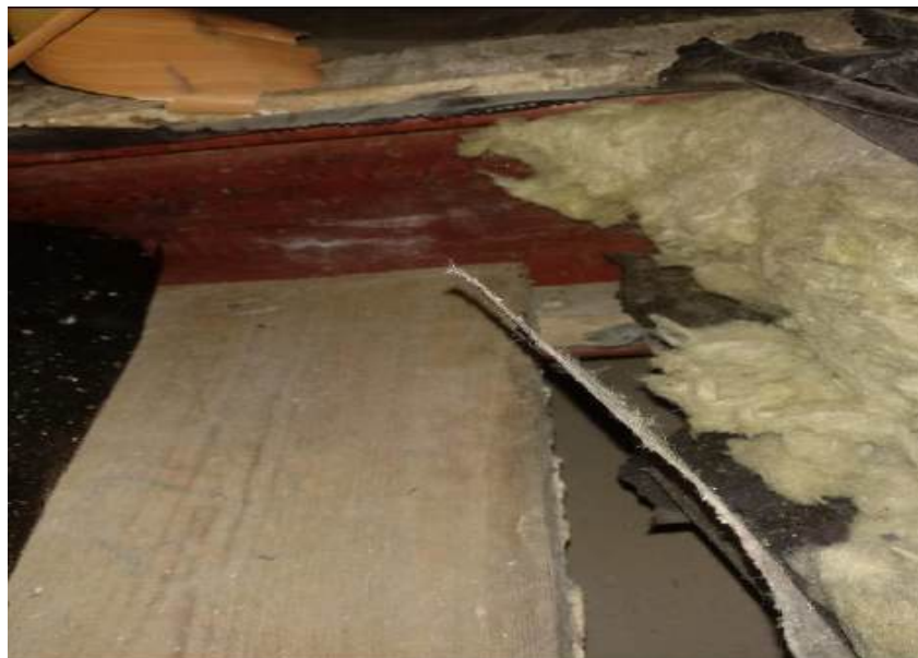
Fot. 68, 69. Na dolnych stopkach belek stalowych widoczne deskowanie ażurowe na którym od góry ułożono wełnę mineralną, od dole sufit systemowy GK.
