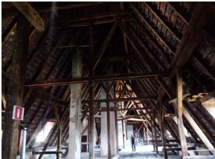
Fot.16. Widok ogólny przestrzeni poddasza i więźby dachowej w części frontowej.
